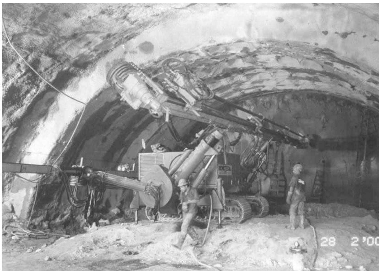
Figura. 1 – Sonda perfo-injetora.
